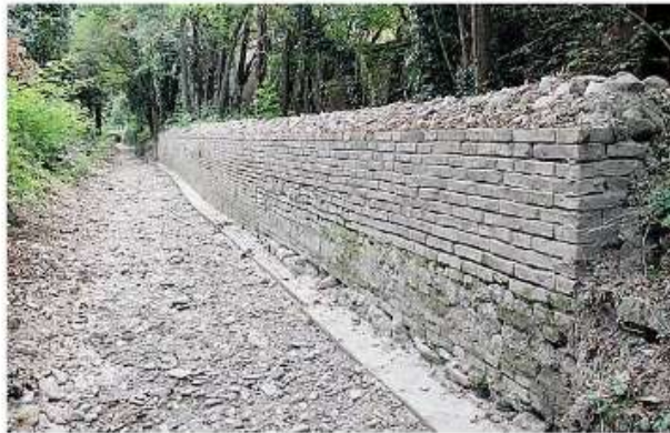
I lavori condotti sul Rio Enzola. A destra, il sindaco Andrea Tagliavini
